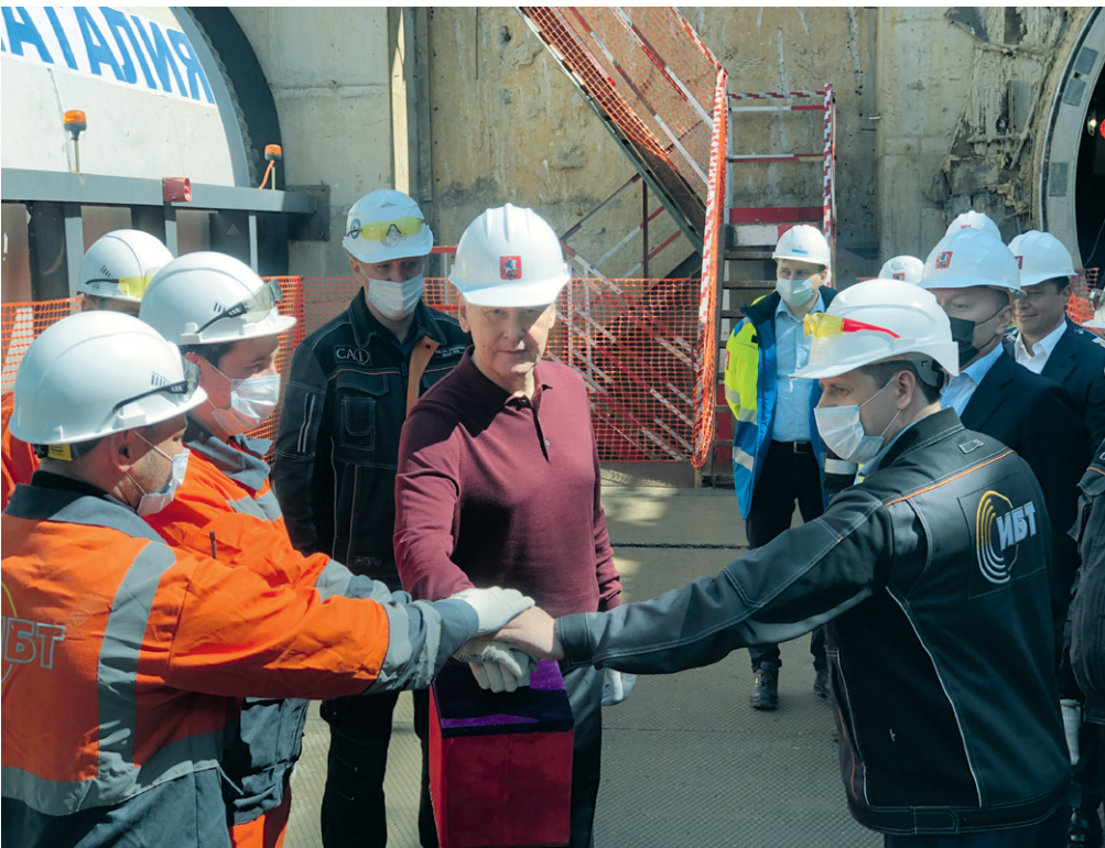
Сергей Собянин дал старт проходке правого метротоннеля от «Пыхтино» до «Расказовки»
