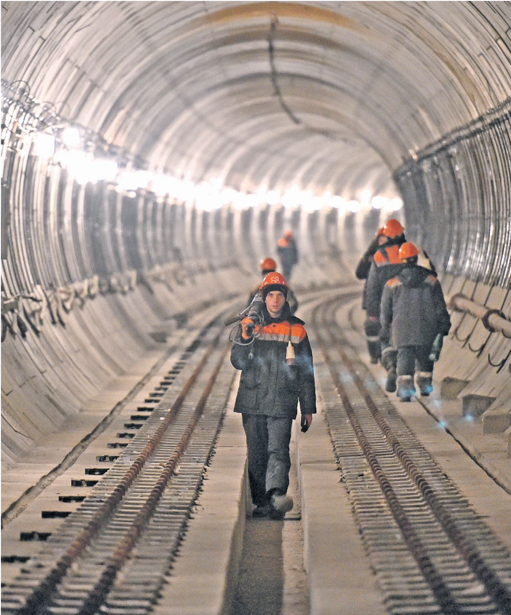
Тоннель на Большой кольцевой линии, построенный при помощи щита диаметром 10 метров
