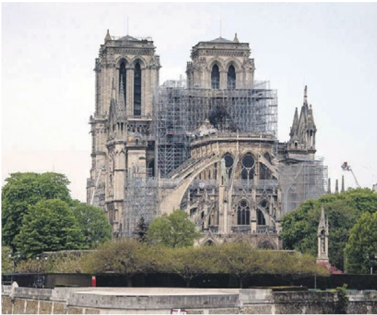
Металлические леса по-прежнему представляют угрозу и могут обрушиться на ту часть потолочного свода, который еще сохранился
