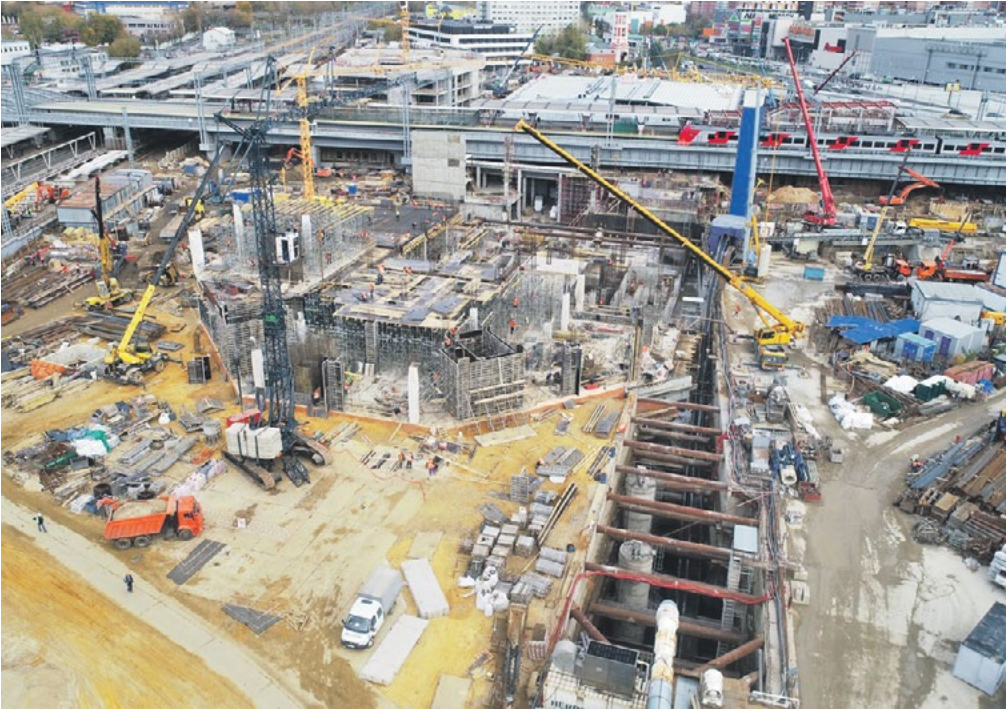
Ход строительства ТПУ «Рязанская»
