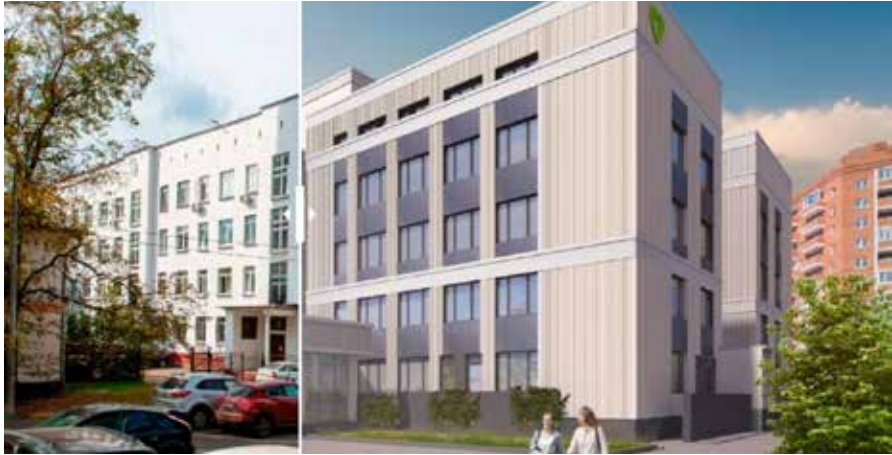
Внешний вид поликлиник изменится, будут заменены коммуникации и проведена комплексная модернизация
