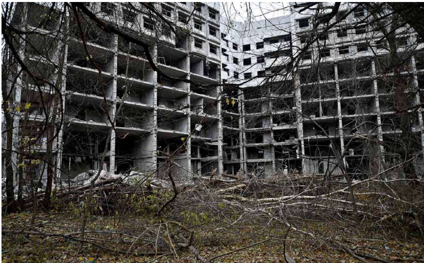
Остов недостроенной Ховринской больницы
