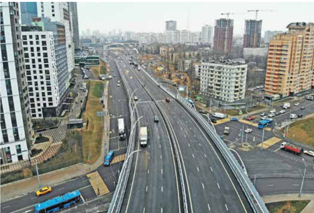
Участок СЗХ, прилегающий к новому Карамышевскому мосту
