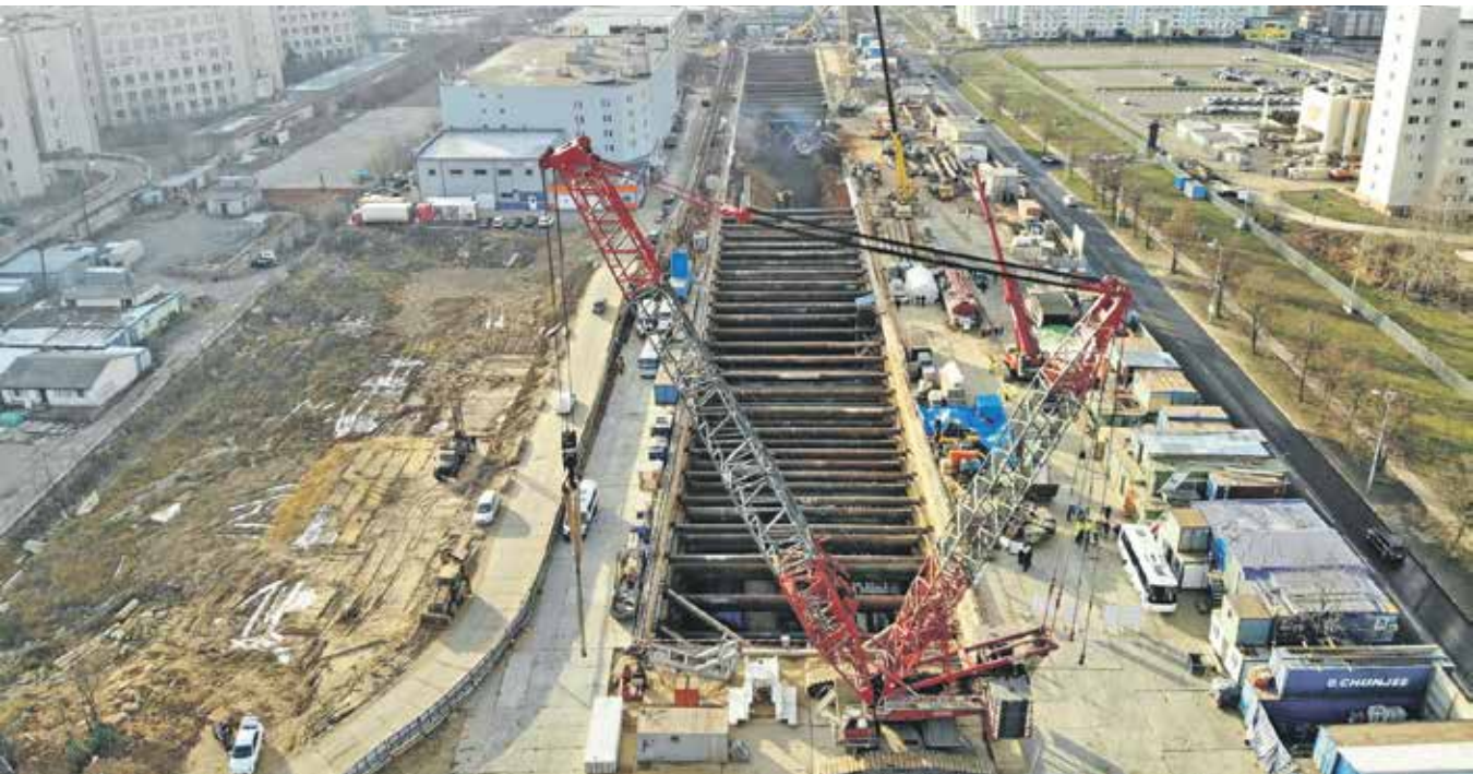
Площадка строительства станции «Университет Дружбы Народов» Коммунарской линии метро
