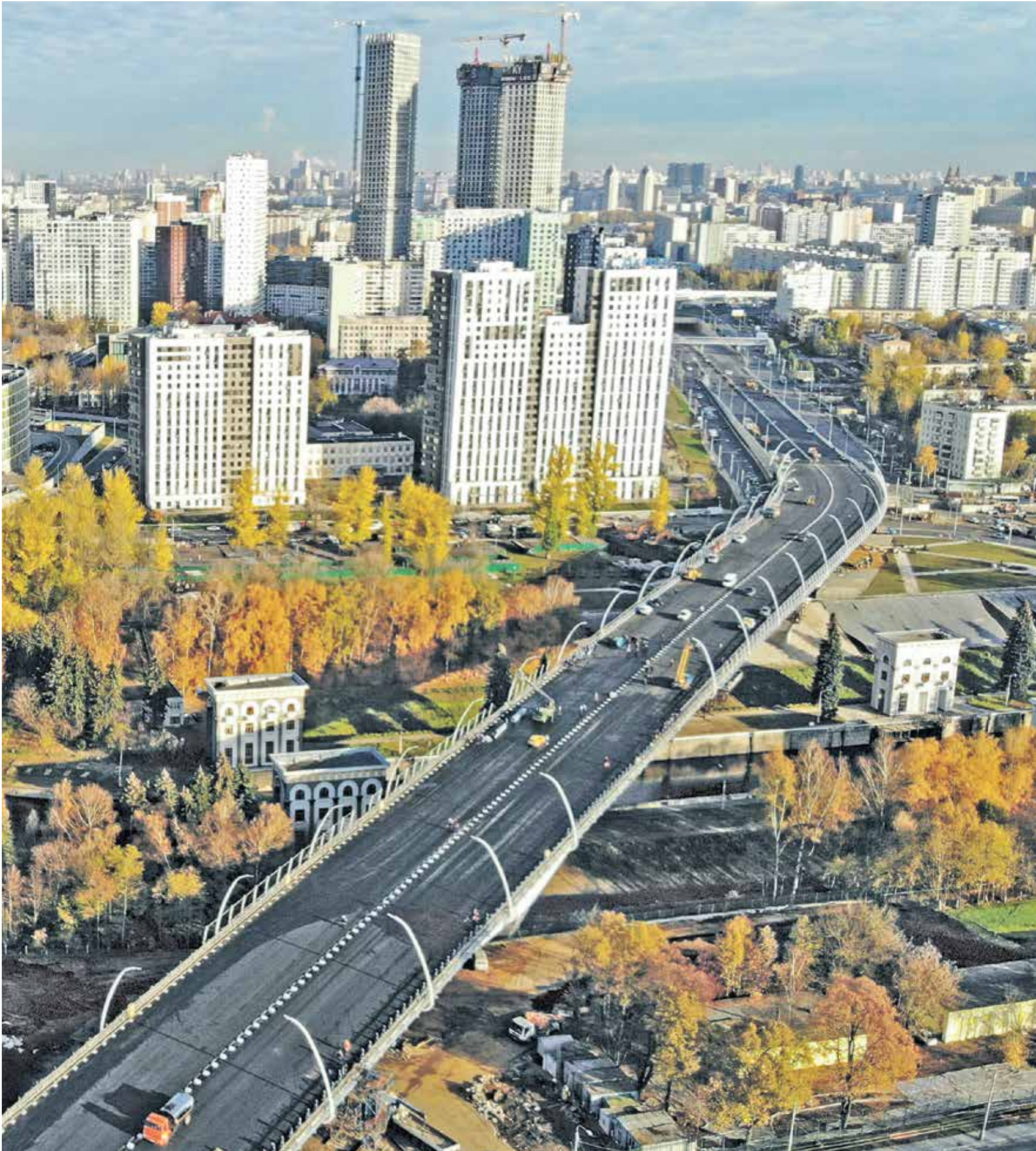
Завершен последний этап строительства Северо-западной хорды
