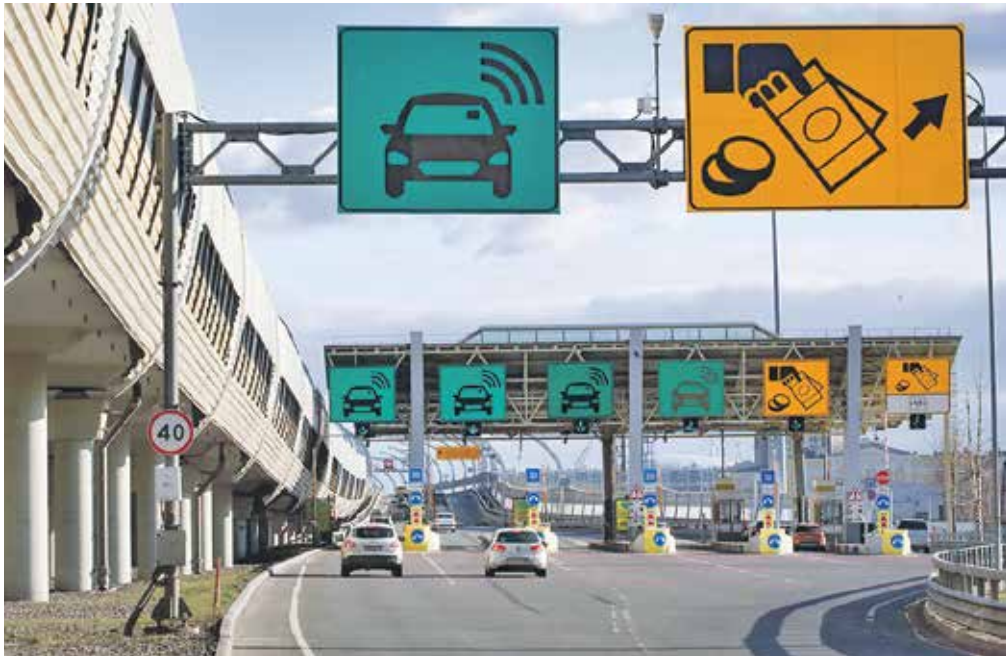
Последний участок платной трассы М11 в Ленинградской области
