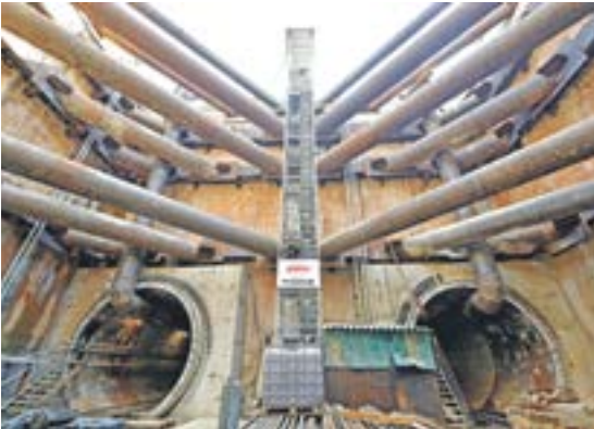
Площадка строительства станции БКЛ «Проспект Вернадского»
