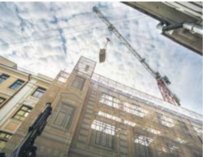
Работы по реконструкции Детского музыкального театра ведутся в стесненных условиях
