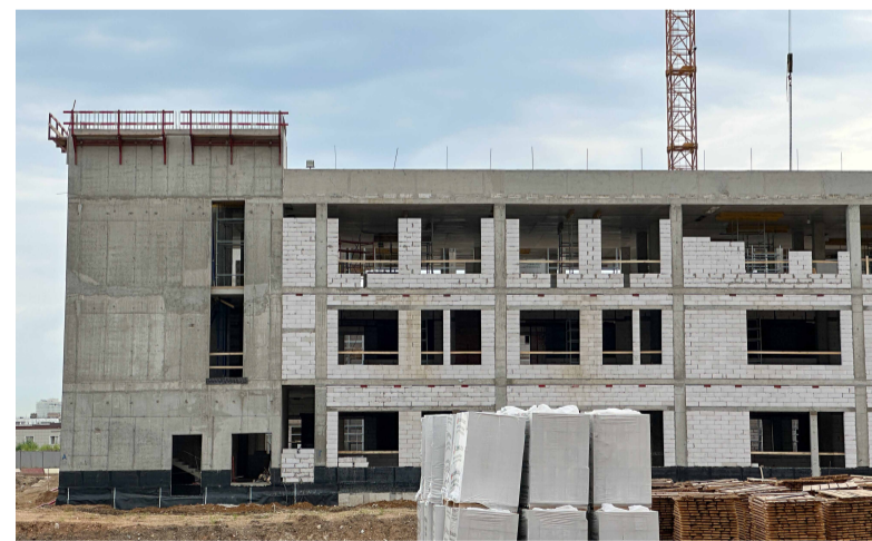
Строительство школы на территории бывшего Черкизовского рынка на востоке Москвы
